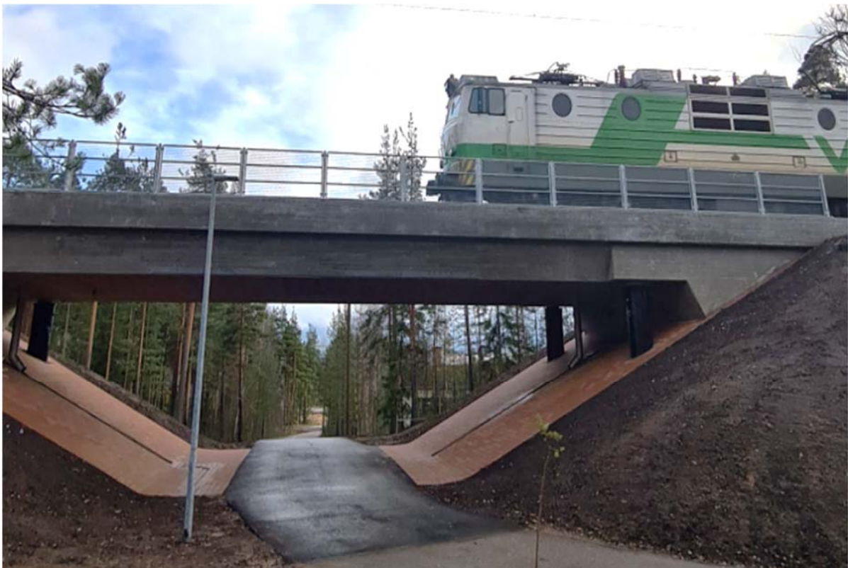
Kuva 42. Oikotien uusi silta valmistuttuaan (Väylävirasto 2022).
