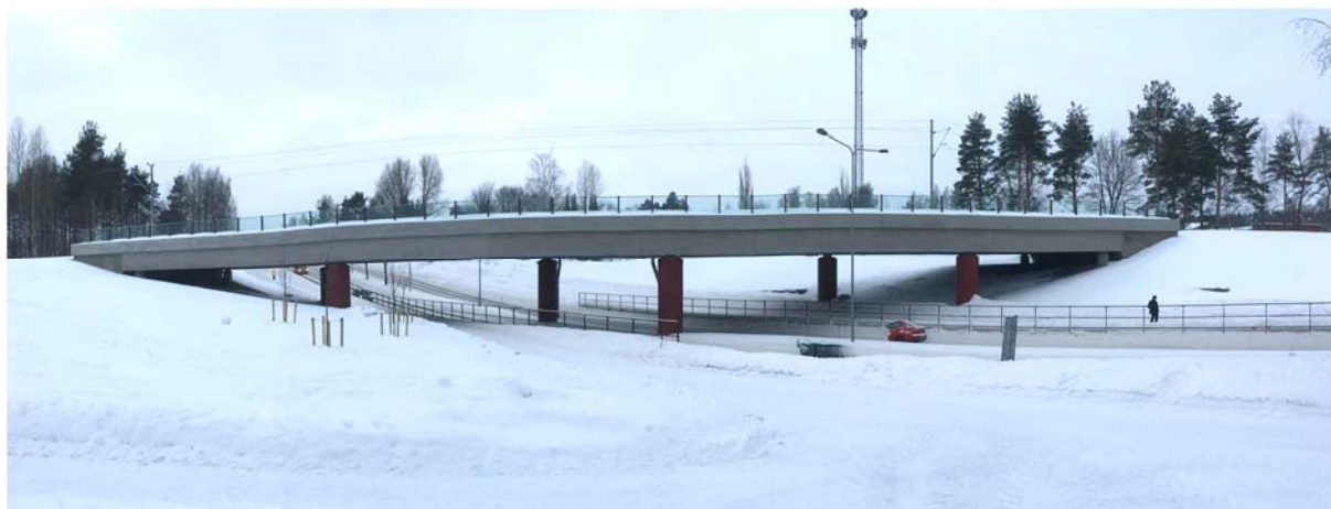
Kuva 16. Hietalankadun uusi ratasilta.
