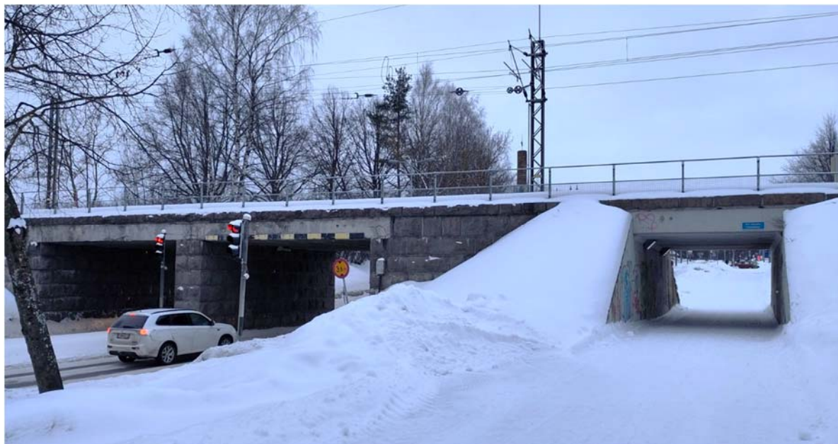
Kuva 15. Vanhan Viipurintien alikulkusilta sekä kevyen liikenteen alikäytäväsilta.
