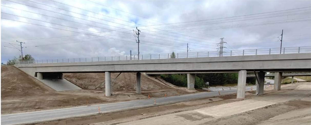
Kuva 43. Hyötiöntien uusi alikulkusilta syyskuussa 2022 (Väylävirasto 2022).
