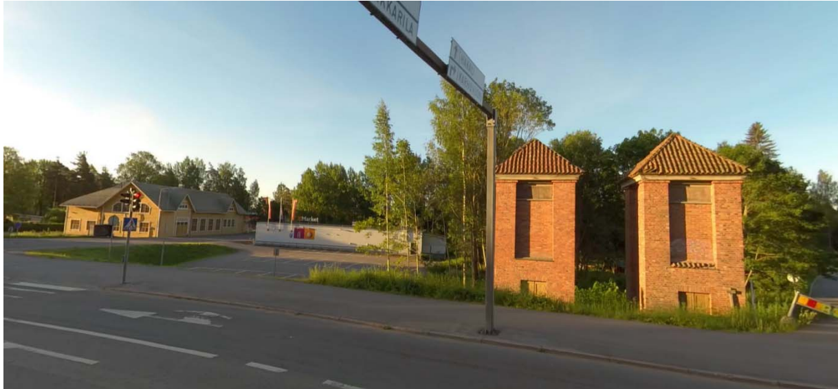
Kuva 40. Tirilän työväentalo, K-market ja Reunakadun muuntamot (Lappeenrannan kaupunki 2021).
