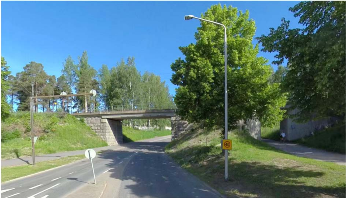
Kuva 41. Standertskjöldinkadun alikulkusilta. Sillan itäpuolella on kevyen liikenteen alikäytävä. (Lappeenrannan kaupunki 2021)
